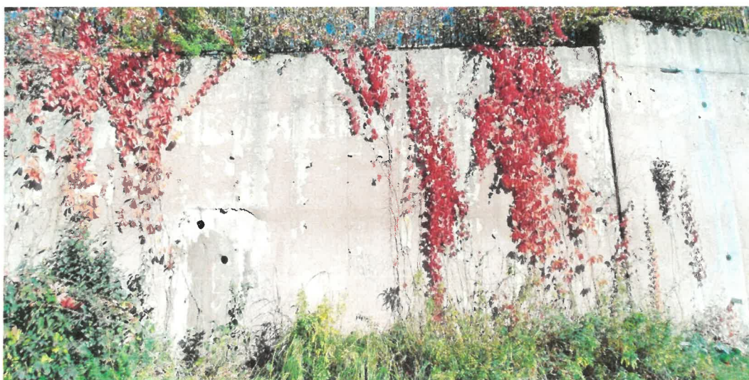
Obr. 2: Pohled na posunutou část opěrné stěny – posunutí pravé části stěny v místě dilatační spáry o cca 60 mm.
