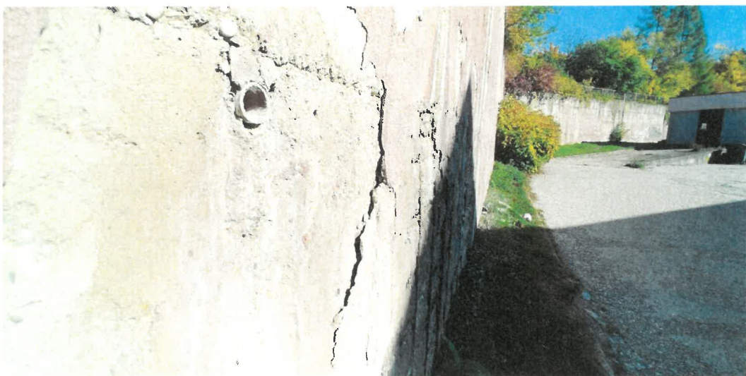
Obr. 6: V konstrukci opěrné stěny byly při výstavbě ponechány PVC průchodky od rozpěrek bednění. Tyto průchodky jsou průběžné, bez jejich uzavření na lící konstrukce.
