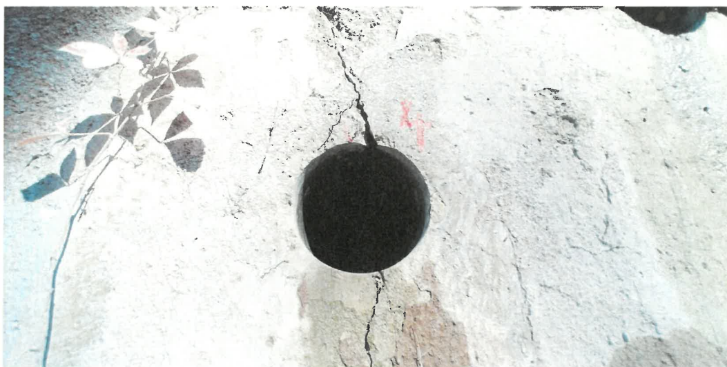
Obr. 18: Sonda po odběru jádrového vývrtu č. 4-T, který byl odebrán v místě svislé trhliny.
