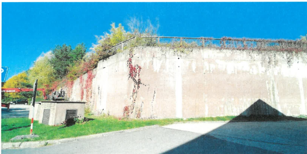
Obr. 1: Pohled na posuzovanou opěrnou stěnu. Na povrch konstrukce byl v minulosti aplikován ochranný nátěr, který je již v současné době nefunkční.
