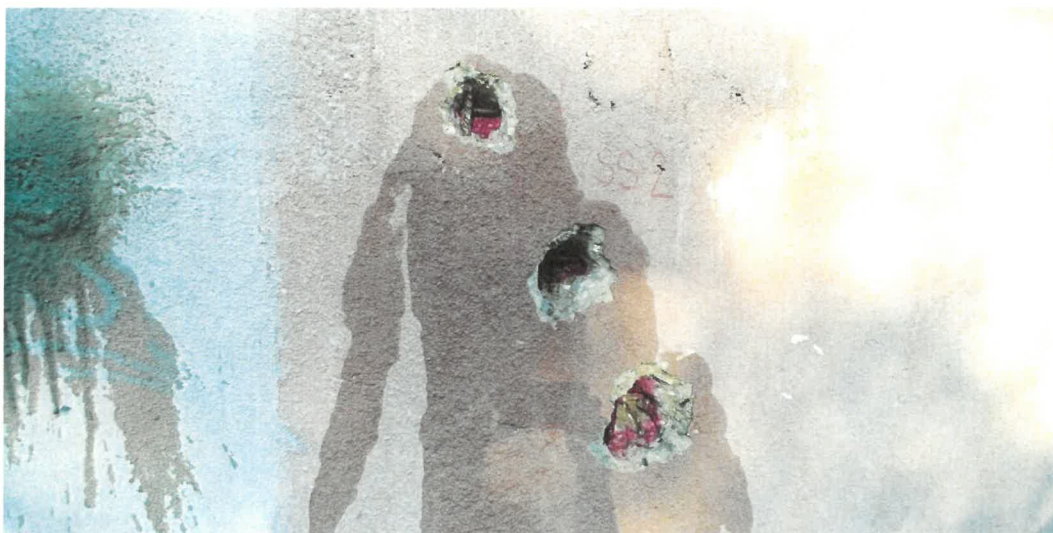
Obr. 10: Sekaná sonda SS2 u paty opěrné stěny.
