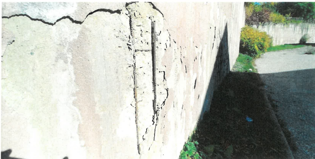
Obr. 7: Odrážení krycí vrstvy betonářské výztuže a koroze obnažené výztuže u paty opěrné stěny.
