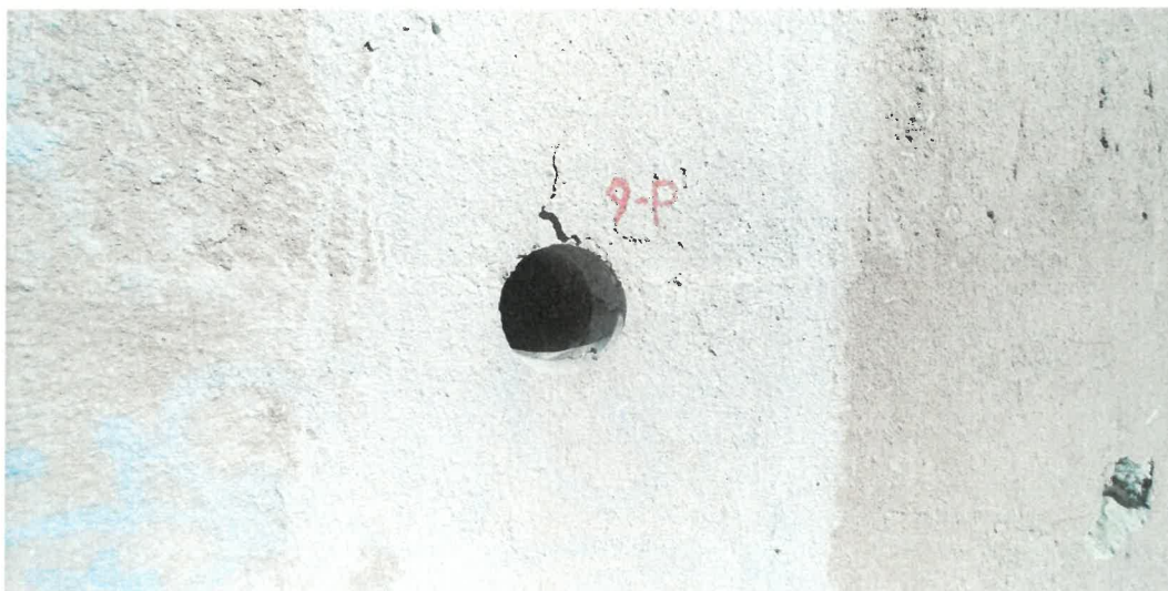
Obr. 22: Sonda po odběru jádrového vývrtu č. 9-P, který byl odebrán v místě vodorovné pracovní spáry.
