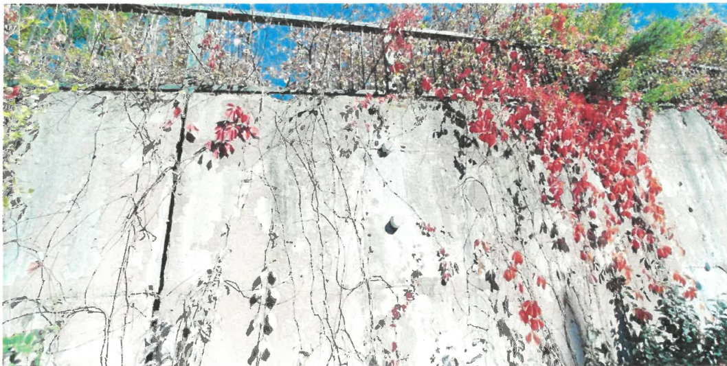
Obr. 4: Pohled na nejvíce rozevřenou dilatační spáru. U opěrné stěny chybí korunová římsa. U koruny opěrné stěny již dochází k rozpadu betonu.
