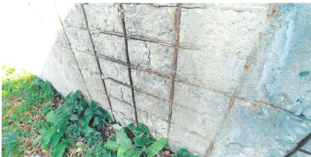
Obr. 8: Celoplošné obnažení prutů betonářské výztuže u paty opěrné stěny. Svislá betonářská výztuž je ukončena ve výšce cca 1,2 m nad úrovní terénu.
