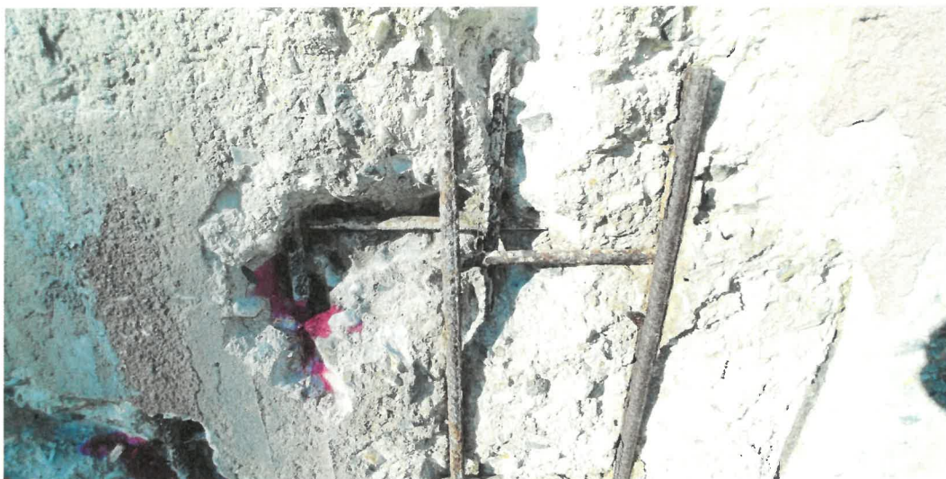
Obr. 13: Detail nevhodného napojování betonářské výztuže přesahem v místě sekané sondy SS3. Výztuž u líce konstrukce má nulovou tloušťku krycí vrstvy.
