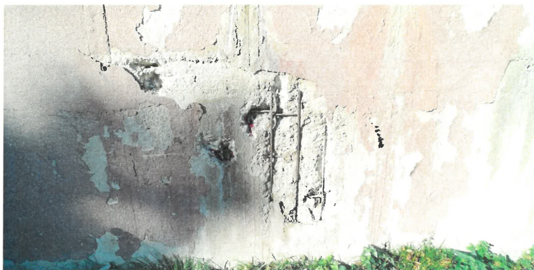
Obr. 12: Sekaná sonda SS3 u paty opěrné stěny.
