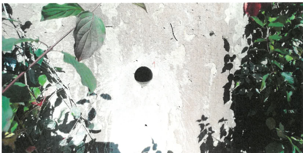
Obr. 14: Sonda po odběru jádrového vývrtnu č. 1.
