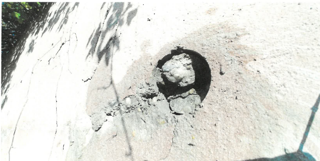
Obr. 28: Sonda po odběru jádrového vývrtu č. 16-P, který byl odebrán v místě vodorovné pracovní spáry. U povrchu konstrukce se ve struktuře betonu vyskytují štěrková hnízda. Na čerstvých lomových plochách byly identifikovány produkty síranové koroze.
