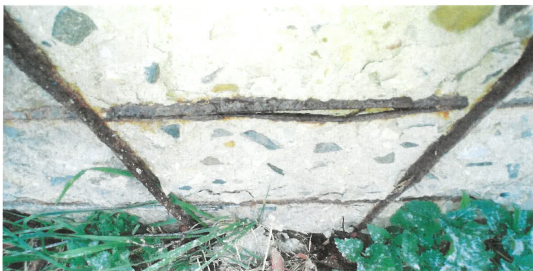
Obr. 9: Detail extrémního narušení prutů betonářské výztuže laminární korozí. Místa byly zjištěny korozní úbytky výztuže o více než 50% původního profilu prutů.
